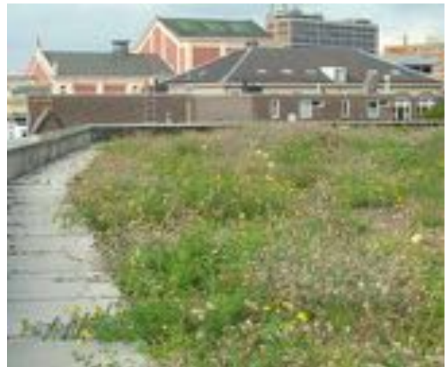
Werkmancollege Groningen (foto's: Sicco van der Brug).
